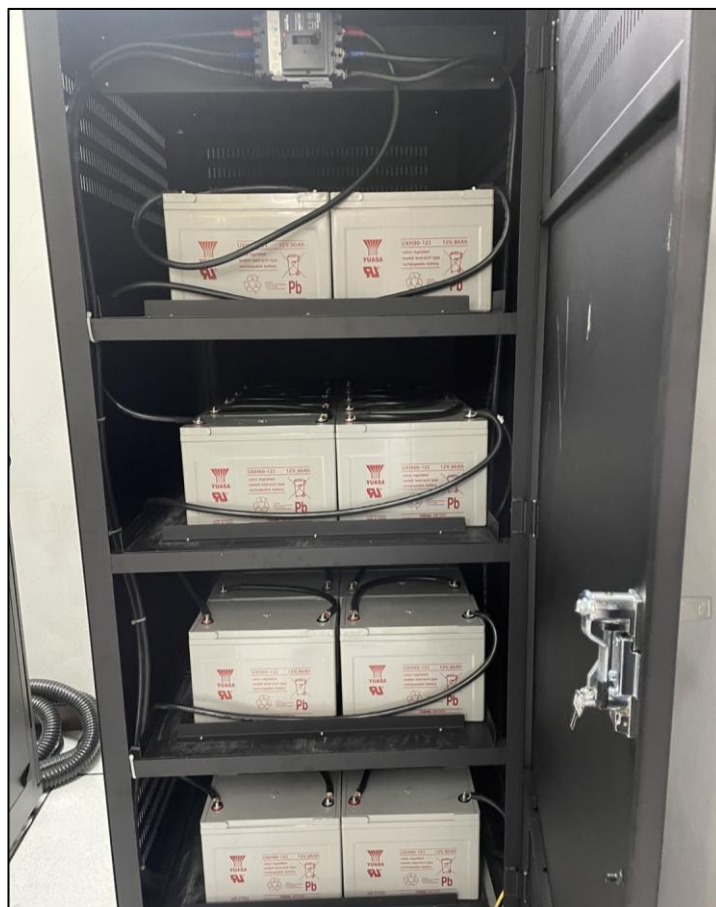
(圖十五)、 75 KVA-UPS 不斷電系統電池箱
