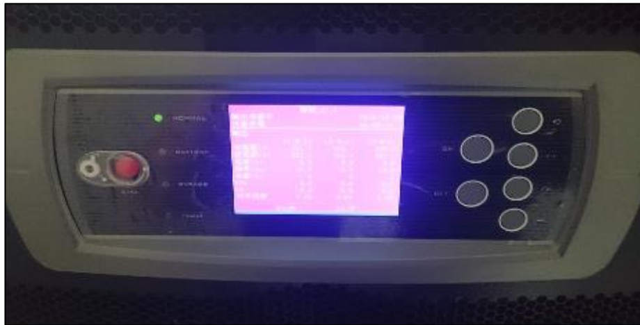
(圖十四)、 75 KVA-UPS 不斷電系統
